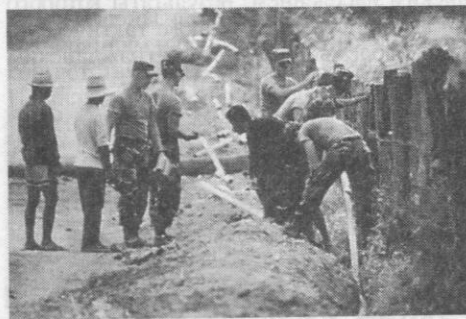
Рис. 2. Прокладка трубопровода военнослужащими армии США в одном из населенных пунктов
